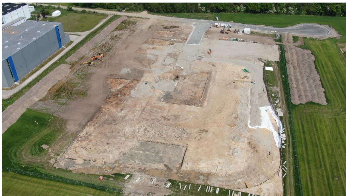
2: Luftbild der Baustelle vom 9. Mai (Bild: Claas Willers)
